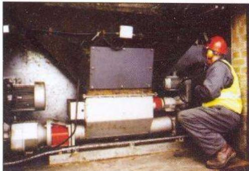
BN064型安装在污水处理厂以控制由于带压脱水机淤泥饼直接进入户外的传送机和开放的料车过程中产生的气味。铸铁BN064型，选择安装了整体防堵器，在要求流量2.5m<sup>3</sup>/h和12bar的压力下输送污泥。每天工作8小时，每周六天，污泥饼每天装满四个封闭的料车。
