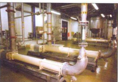
共有9台BN系列的不锈钢泵已经安装在格林威治的一家工厂沿着几百米的管线输送高粘度的物质。工作转速在123 rpm至196 rpm之间，压力在3到8bar之间，以4.5m<sup>3</sup>/h到40.5m<sup>3</sup>/h的流量输送面筋。,鉴于泵必须24小时运行，每周7天，及最少的停机修理时间，客户对泵提出了极高的可靠性要求。
