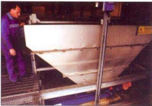
安装在大型污水处理厂内的污泥脱水单元是一个带式浓缩系统，带宽3×3m，0.73mm的网眼，位于积水坑的上端。当脱水污泥饼到达带的末端，落入BN072泵的进料斗，以14m<sup>3</sup>/h的流速输送到泥饼池。BN系列泵特别适合输送粘稠不流动的污泥和泥浆。使用大螺旋推进系统有助于污泥进入泵吸入腔而无挂料或堵塞。
