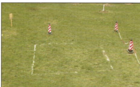
第三步 现场土建勘察
