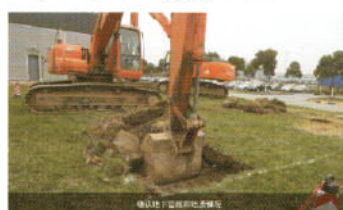
第四步 开始挖泵坑
